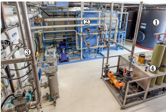
Figures 3 et 4 : ① Stripping CO<sub>2</sub>, ② Skid de décantation et filtre à sable, ③ Filtres, ④ Installation de stripping membranaire ammoniacale.
