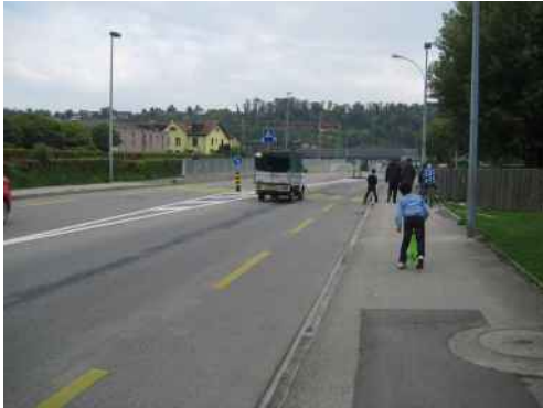
Chemin de la Sallaz Trottoirs larges et surélevés le long des routes à orientation trafic
